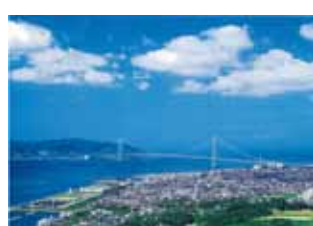
兵庫 -039 明石海峡大橋 4992617425986
