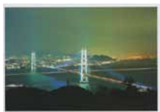
兵庫 -019 明石大橋 4992617206721
