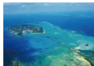
沖縄 -088 宮古島池間大橋 4992617424651
