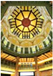
東京 -120 東京駅復原 - ドーム内装 4992617413815
