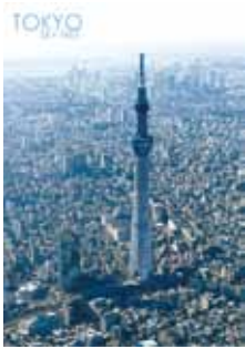
東京 -112 ビル街を背景にそびえる東京スカイツリー 4992617412047
